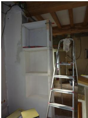
Réalisation du coin TV et de l'entrée de la future cuisine. L'ensemble est bâti à partir de béton cellu-
