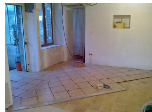
Vient ensuite la pose du carrelage avec un paillasson disposé à l'entrée.
