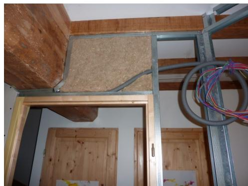
Le câblage est passé en hauteur dans l'isolant.
