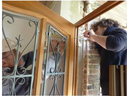
De nombreuses pattes de fixation et vis sont insérées sur les montants verticaux.
