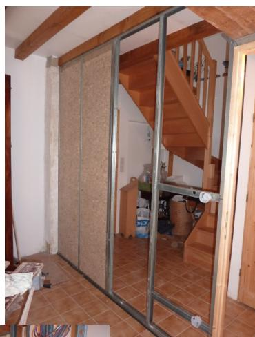
Avant la pose des plaques de BA13, des panneaux de laine de chanvre sont insérés.
