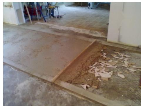
Entre chaque nue, du béton est étalé à la règle sur un treillis métallique et des chutes de carrelage.
