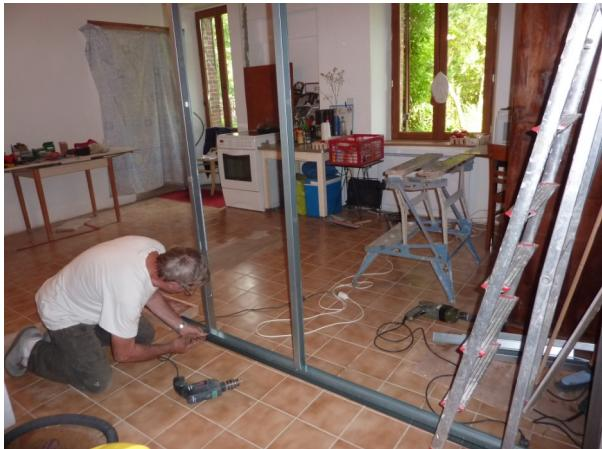
Un rail métallique est fixé au sol avec comme isolation une bande résiliente. Même opération au plafond. Des montants verticaux sont alors insérés dans ces rails ; tout en respectant une distance entre eux multiple de 60cm (futures plaques de BA13)
