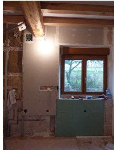
La pose de plaques de BA13 est ensuite entreprise avec une mise en attente des travaux de plomberie prévus à l'emplacement du futur évier. Des ouvertures sont réalisées pour l'alimentation des différents appareils électriques
