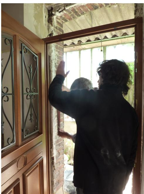
Nous ne sommes pas trop de deux pour présenter la nouvelle porte ! Il s'agit de la stabiliser dans une verticalité et une horizontalité effectuées dans les règles de l'art !
