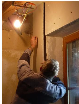
Après avoir réparti des plots de colle, les plaques sont positionnées et permettent
